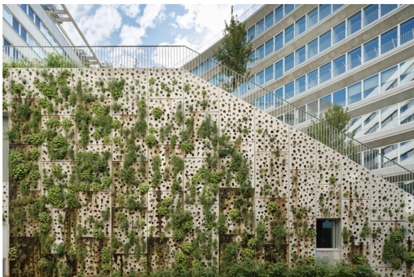
Figure 3. Mur biodiversitaire en panneaux préfabriqués en béton, enceinte du jardin du siège de l'AP-HP (Paris, été 2022)
